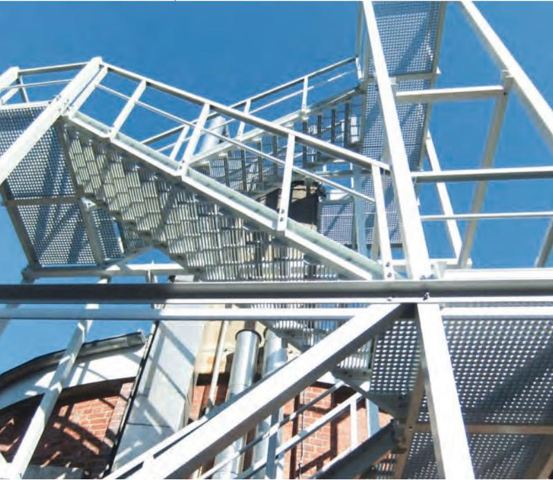
*Die GFK-Treppentürme werden bis zu einer Höhe von 30 Metern gebaut.*
