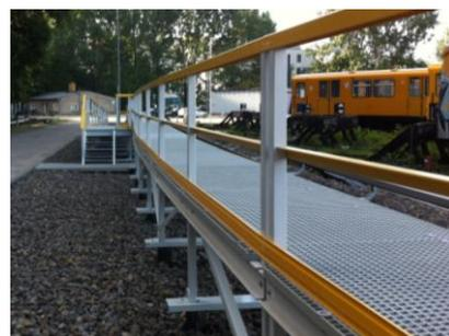
Durch die CTS Modulbauweise und dem Einsatz von Punkt-Fundamenten konnte die komplett aus GFK gefertigte Anlage in deutlich kürzerer Zeit errichtet werden als herkömmliche Konstruktionen aus Beton, Stahl oder Holz. Insgesamt wurden 500m Dienstwege und Laufsteganlagen in einer Länge von 180m errichtet.
