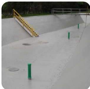
Beschichtung mit Treppe
