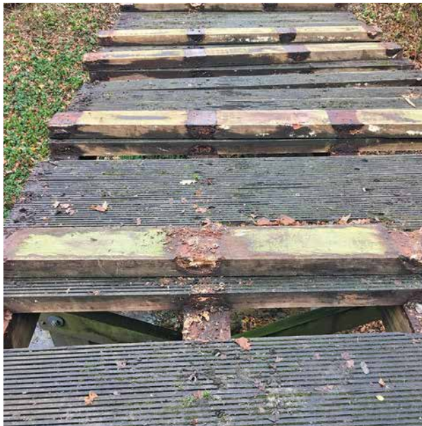
Zerstörung durch Feuchtigkeit
