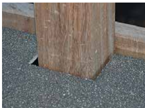
Aussparung Geländerpfosten
