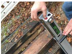
Widerstandsmessung der Holzträger
