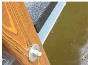
Seitliche Abdeckung mit Winkel
