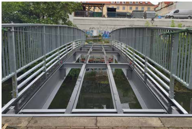
Aufdoppelung Stahlträger mit PE
