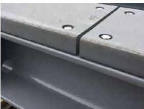
Aufdoppelung mit Kunststoff
