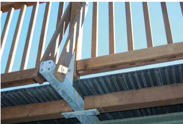
Montage mit Überstand (Kragarm)
