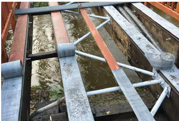
Aufdoppelung mit Holz, EPDM als Trittschallschutz
